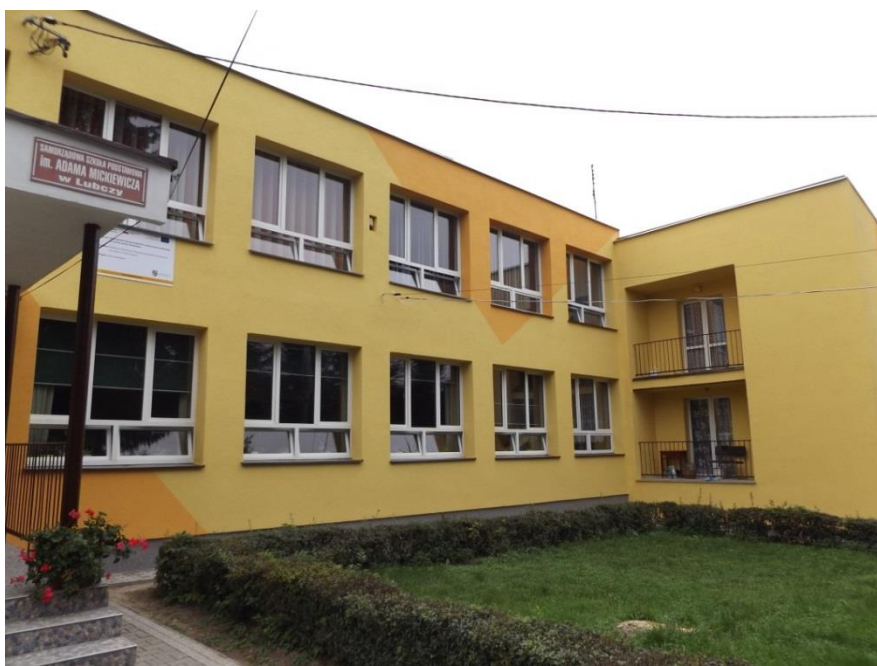
Zdjęcie. Budynek samorządowej Szkoły Podstawowej w Lubczy po termomodernizacji
